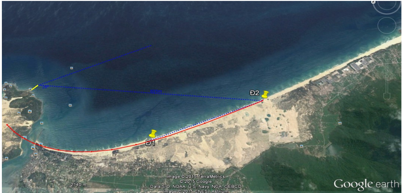
Hình 3-8. Dự báo vị trí đường bờ sau khi xây dựng công trình, PA 3
