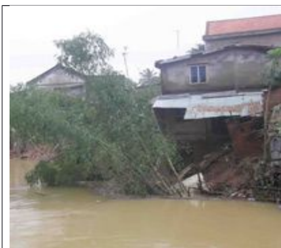
Hình 2: Sạt lở khu dân cư trên bờ Hữu sông Túy Loan (Đà Nẵng)
