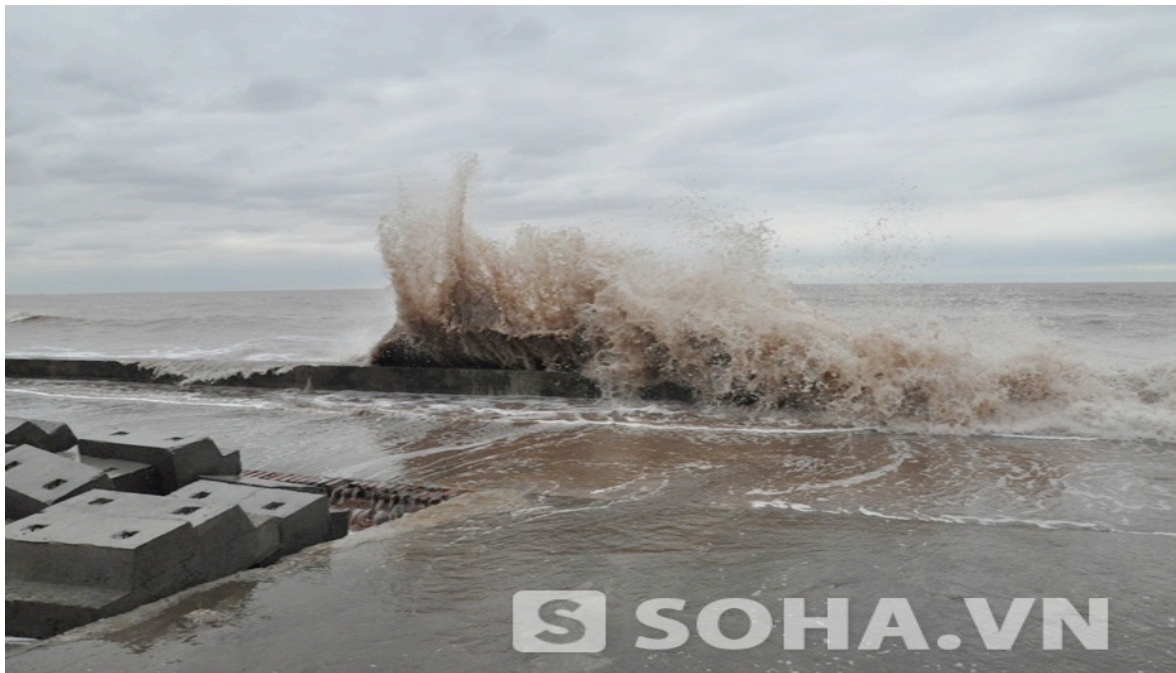
Hình 1. Sóng tràn qua đê bãi biển Quát Lâm
